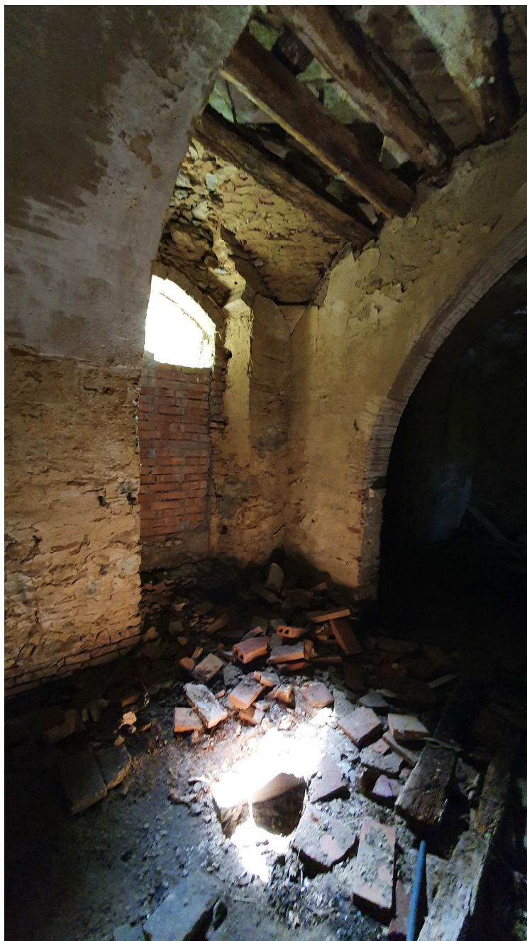
Fig. 12: Degrado architettonico e strutturale al piano seminterrato (rif. Documentazione Fotografica foto 12 - Vista di un locale del piano seminterrato)
