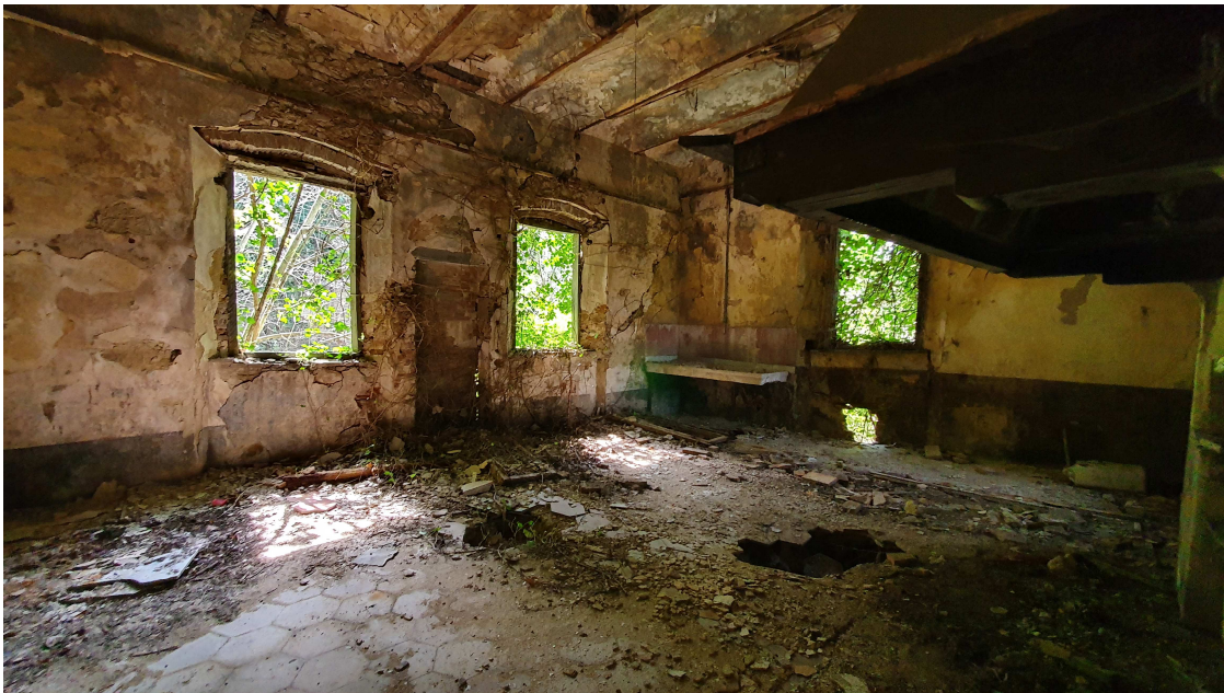
Fig. 10: Vegetazione infestante esterna, mancanza totale di infissi e degrado architettonico e strutturale (rif. Documentazione Fotografica foto 2 - Cucina piano terra)
