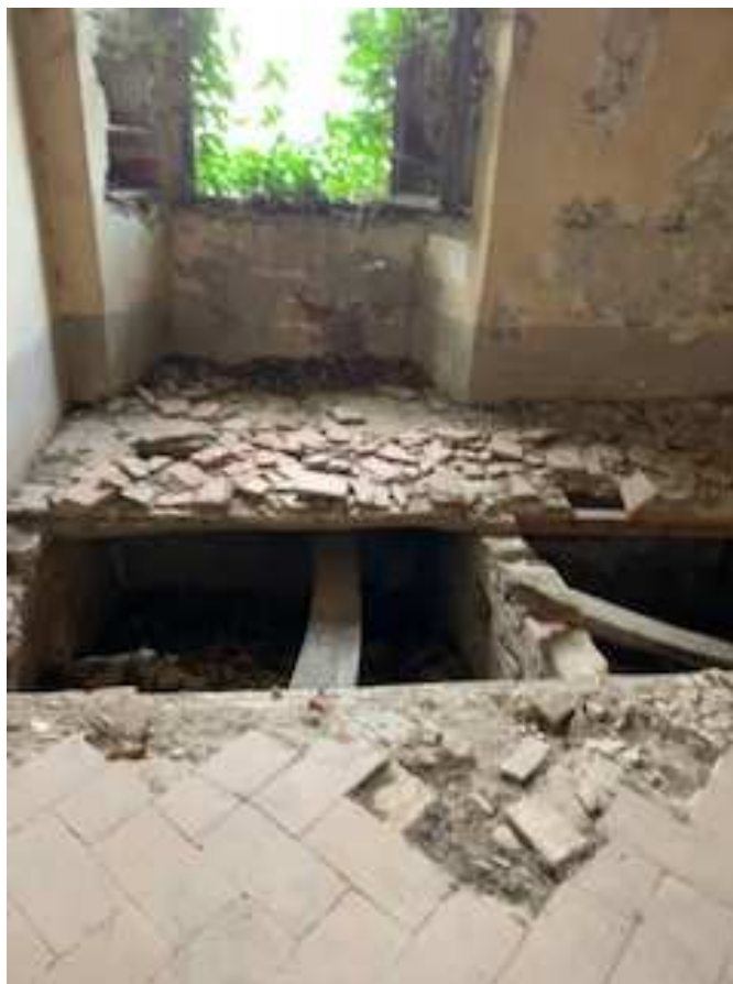
Fig. 18: Degrado architettonico e strutturale, totale mancanza di infissi e vegetazione infestante al piano primo (rif. Documentazione Fotografica foto 35 – Particolare di solaio crollato al piano primo)
