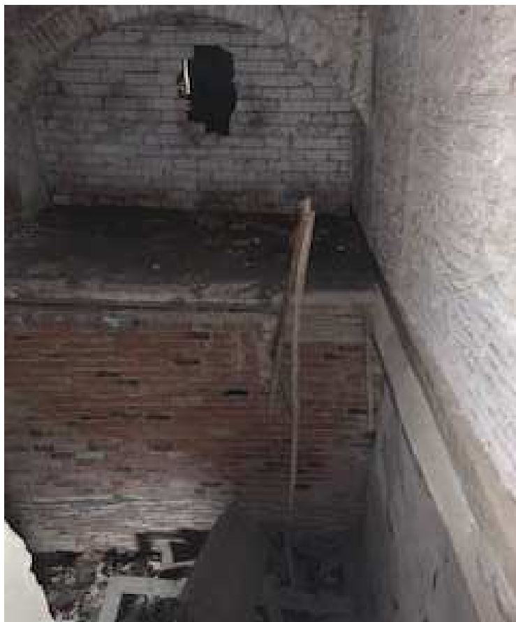
Fig. 13: Orizzontamento crollato al piano ammezzato (rif. Documentazione Fotografica foto 14 - Veduta di un solaio crollato piano ammezzato)
