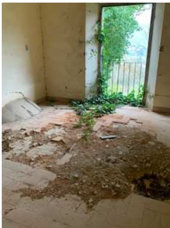
Fig. 17: Degrado architettonico e strutturale, totale mancanza di infissi e vegetazione infestante al piano primo (rif. Documentazione Fotografica foto 31 – Dissesti di solai del piano primo)
