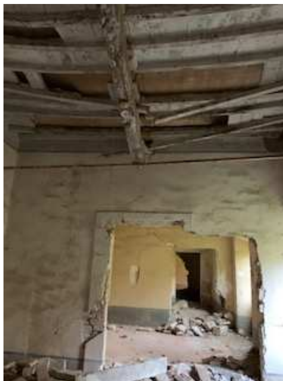
Fig. 18: Degrado architettonico e strutturale, totale mancanza di infissi e vegetazione infestante al piano primo (rif. Documentazione Fotografica foto 35 – Particolare di solaio crollato al piano primo)
