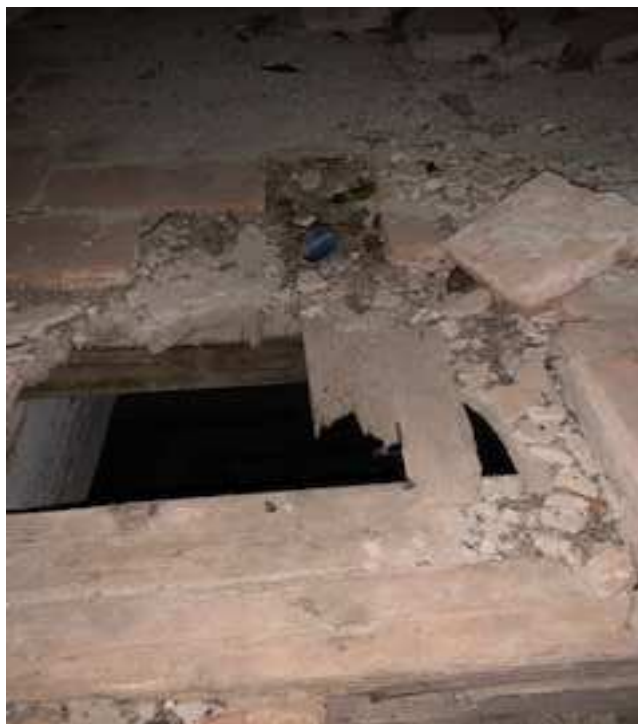
Fig. 13: Orizzontamento crollato al piano ammezzato (rif. Documentazione Fotografica foto 14 - Veduta di un solaio crollato piano ammezzato)
