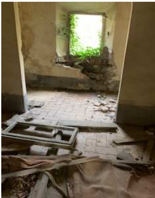
Fig. 16: Degrado architettonico e strutturale, totale mancanza di infissi e vegetazione infestante al piano primo (rif. Documentazione Fotografica foto 29 - Vista di uno dei locali del piano primo)
