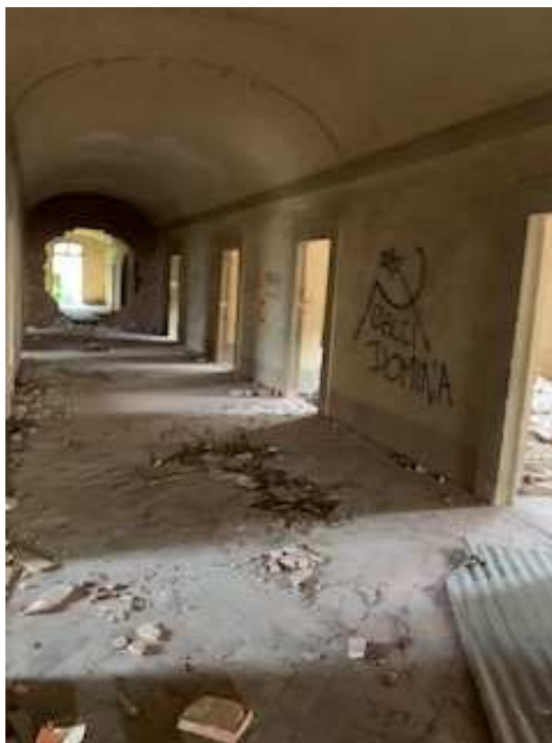
Fig. 15: Degrado architettonico e strutturale e totale mancanza di infissi al piano primo
