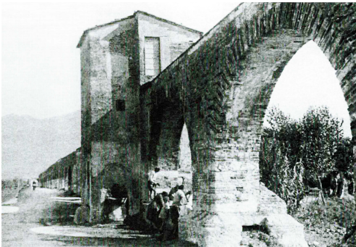
Fig.27 L'acquedotto mediceo in prossimità della fonte e della cisterna del Ticcio (oggi di questa struttura rimane solo una vestigia) nei pressi dell'attuale attraversamento carrabile di via Bellini. Si noti in primo piano sia lo 'zattera' di fondazione molto emergente (oggi, viceversa, solo affiorante) sia la differente tipologia di ghiera unica in tutto il tracciato, da GASPERINI M., GRECO G., M. NOFERI N., TAGLIAGAMBA S., 2015, p.157.
