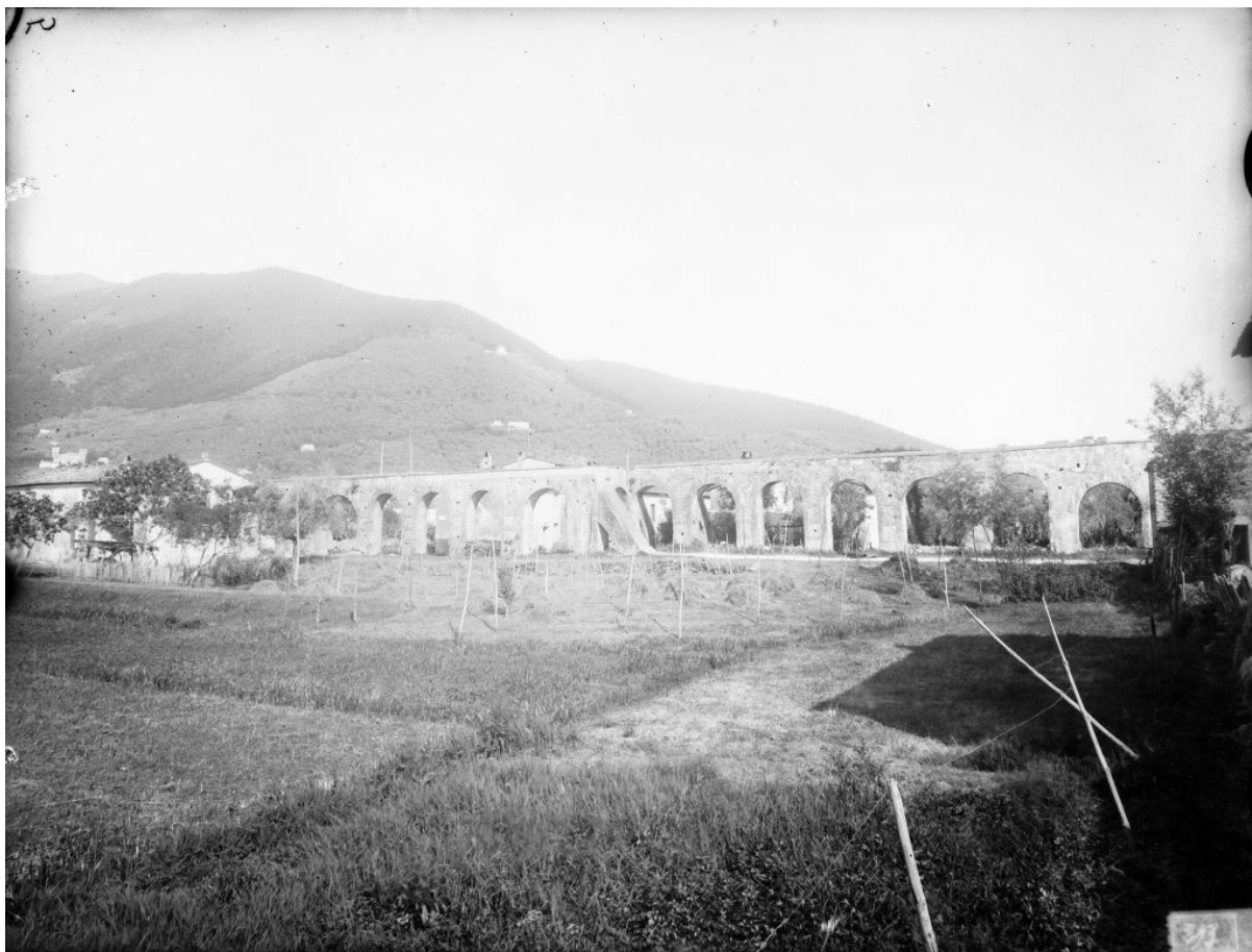
Fig.28 L'acquedotto mediceo in prossimità degli archi nn. 556 al n.568. Gli archi dal n 554 al n.563 (in corrispondenza del Fosso della Vicinaia) sono stati oggetto di ricostruzione a causa dei danni indotti dal sisma del 1846. Si noti lo 'sperone rampante' in laterizio che si attesta sull'oggi non più esistente (A.F.S.Pi Brandi, post1850 ante1920)
